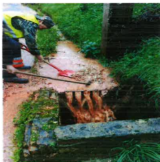
Limpeza de sumidouros e aquedutos Tempestade Kristin
